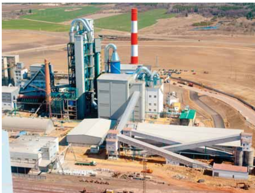
Новая линия по производству клинкера на ОАО «Красносельскстройматериалы» (совместно с СІТІС)
